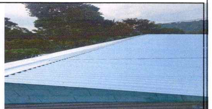
Foto 4: MÓDULO 1 AULAS MANTENIMIENTO A ESTRUCTURA DE SOPORTE DE METAL
