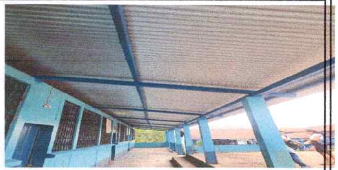
Foto2: MÓDULO 1 AULAS CAMBIO DE LÁMINA, POR LÁMINA ACANALADA ALUZINC CALIBRE 26
