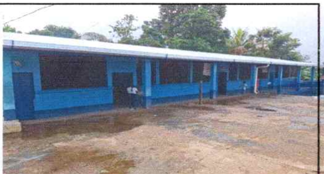
Foto3: MÓDULO 1 AULAS CAMBIO DE LÁMINA, POR LÁMINA ACANALADA ALUZINC CALIBRE 26
